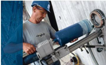
Particulièrement puissant, l'appareil de forage diamant GDB 2500 WE Professional perce le béton armé sans vibration.
