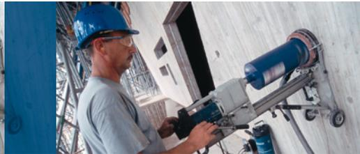
Avec le support de perçage S 500 A Professional, l'appareil de forage diamant est parfaitement plaqué contre le mur.
