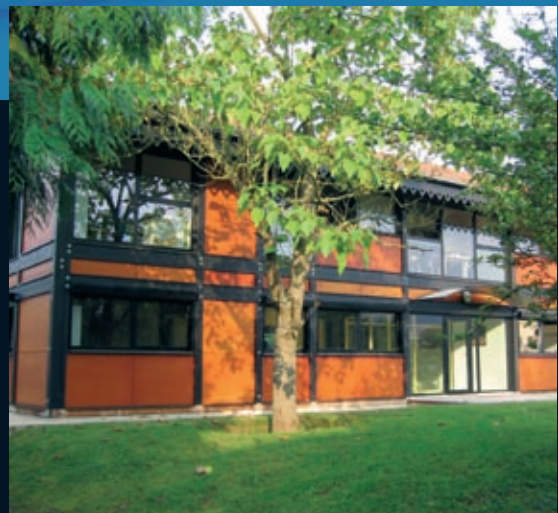
FSH WELDING GROUP Siège - France
