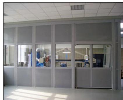
Lorsqu'il est envisagé de créer une séparation d'un poste de travail jusqu'au plafond, la mise en place d'un système de cloisons insonorisantes s'impose.
